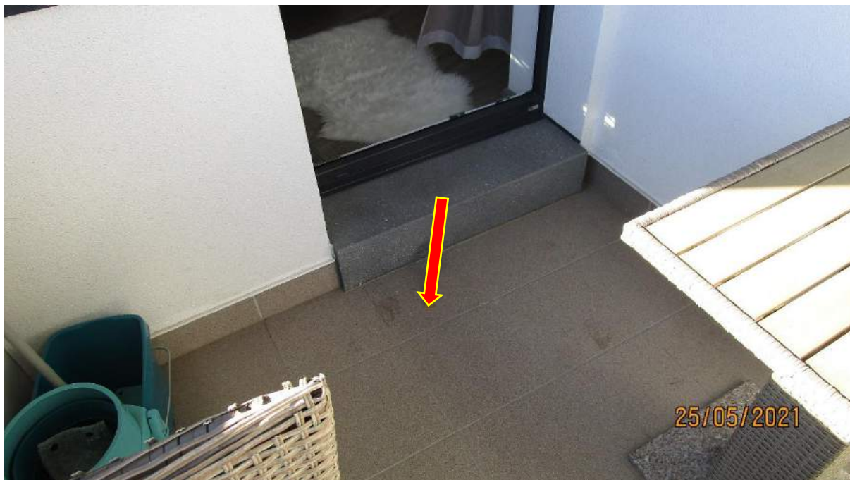
68) dlaždice nedrží na podkladu – při poklepu vydává „dutý“ zvuk
