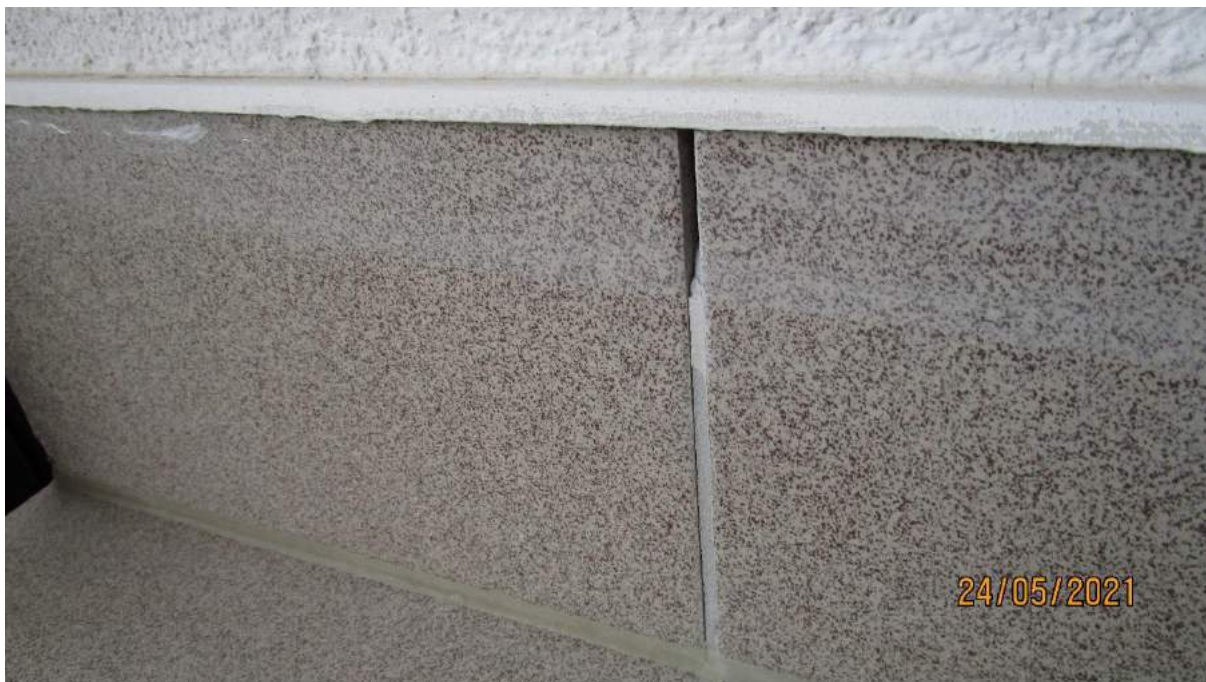
48) spárovací hmota je vydrolená ze spáry soklu
