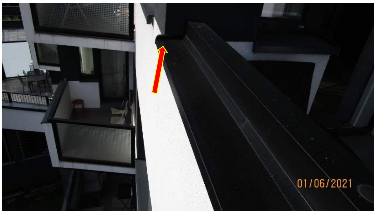
127) parapet nedrží na podkladu
