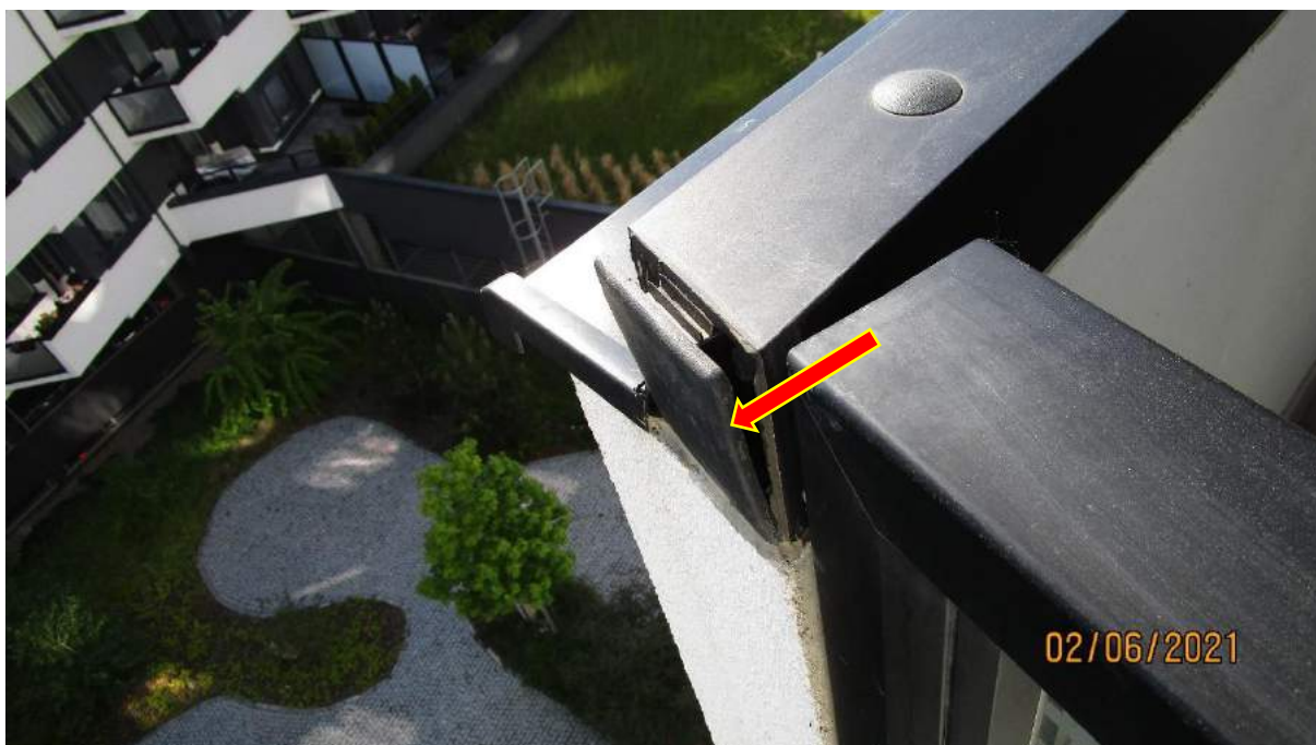
137) ndrží ucpávka profilu zábradlí
