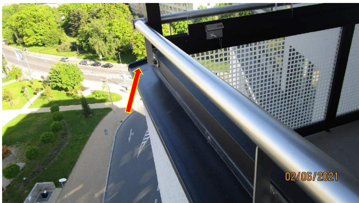
149) parapet nadrží na podkladu
