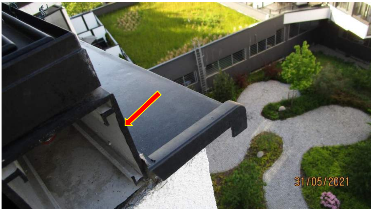
135) koncovka profilu nedrží a zcela upadla
