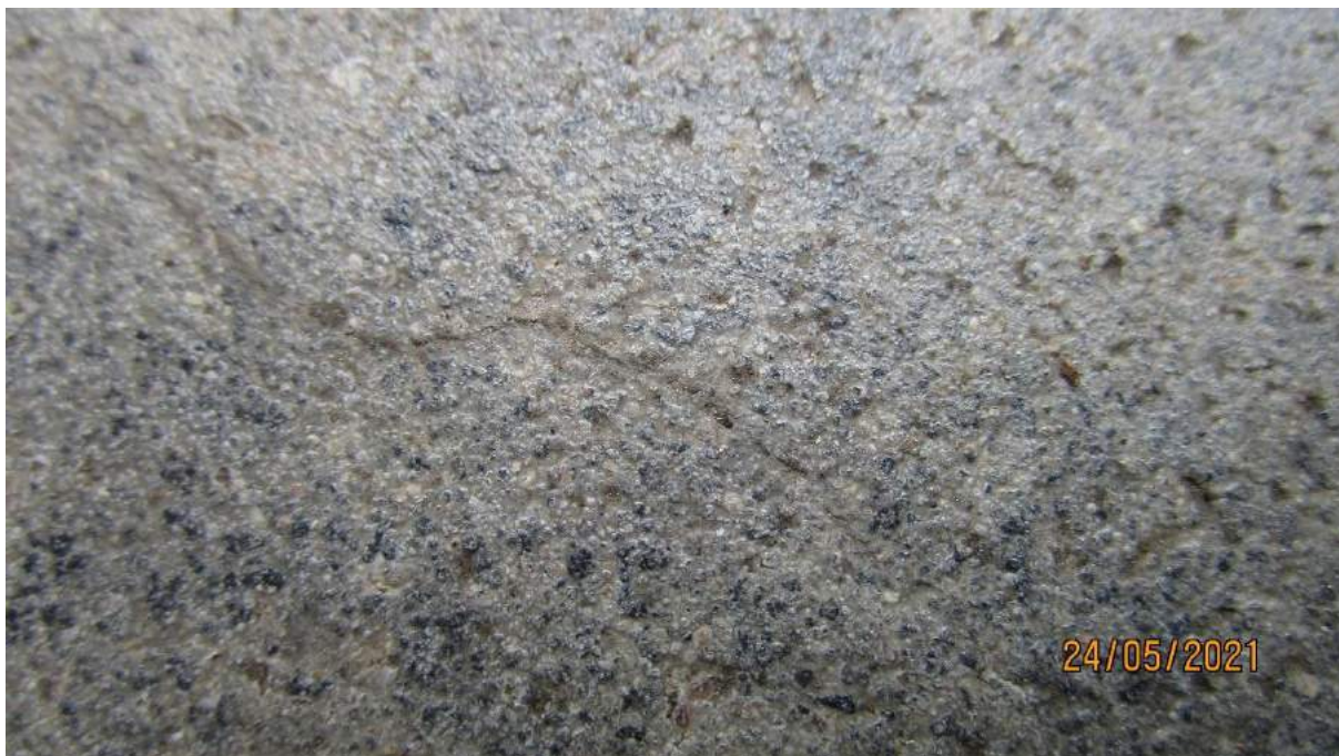
46) prasklina v dlaždici
