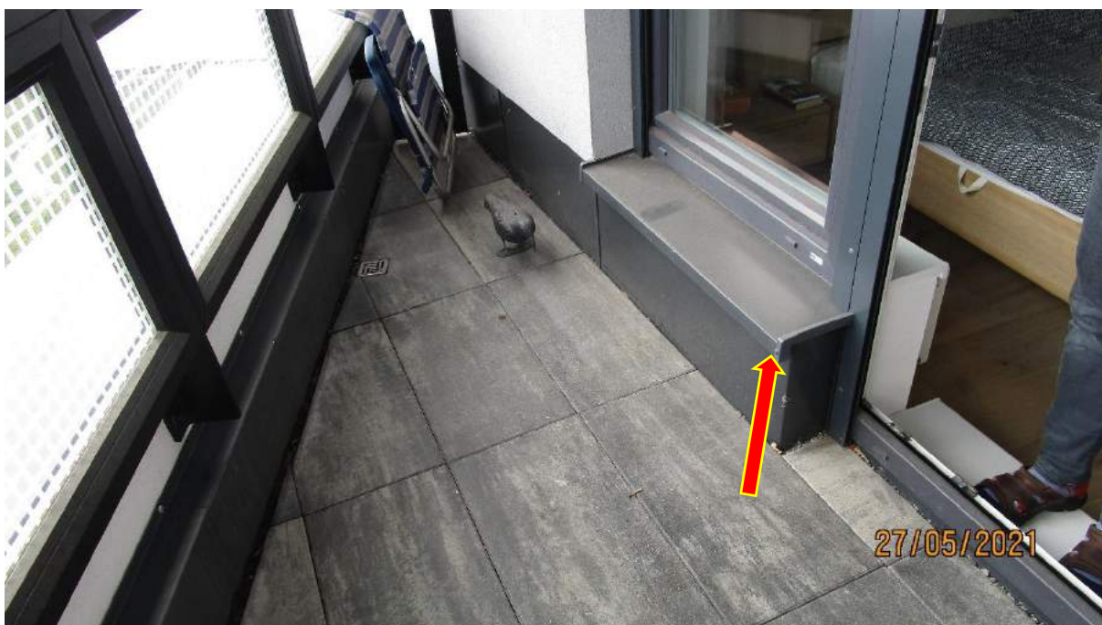
100) parapet nadrží na podkladu
