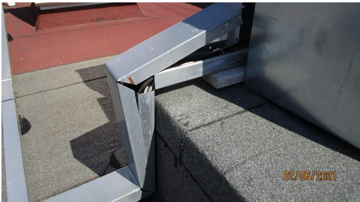
25) víko žlabu ne drží na žlabu
