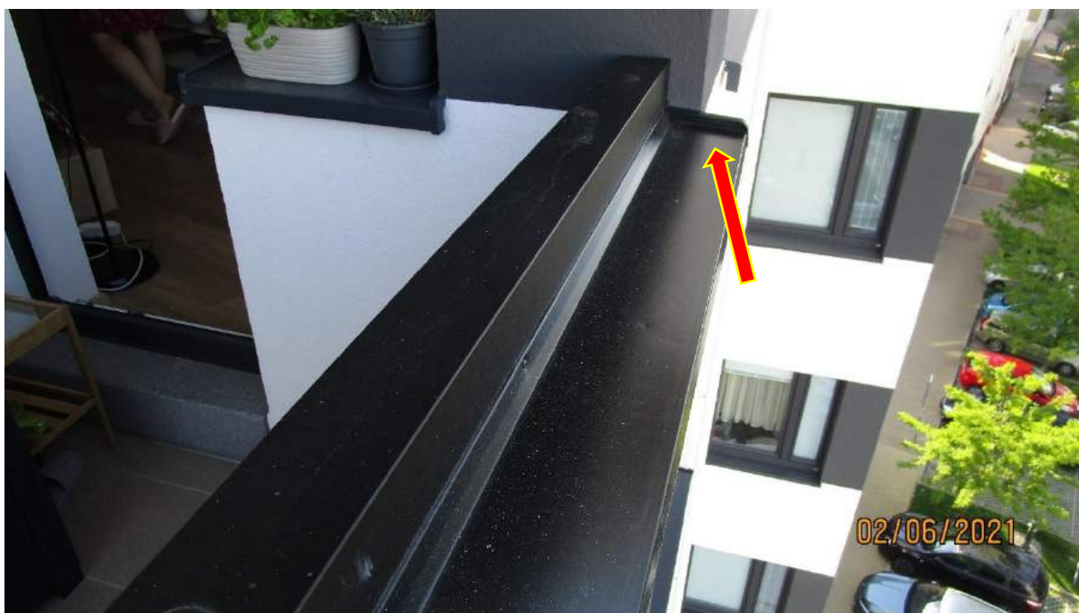
138) parapet ndrží na podkladu
