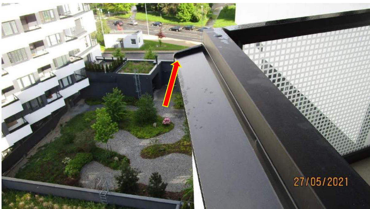
92) parapet nadrží na podkladu
